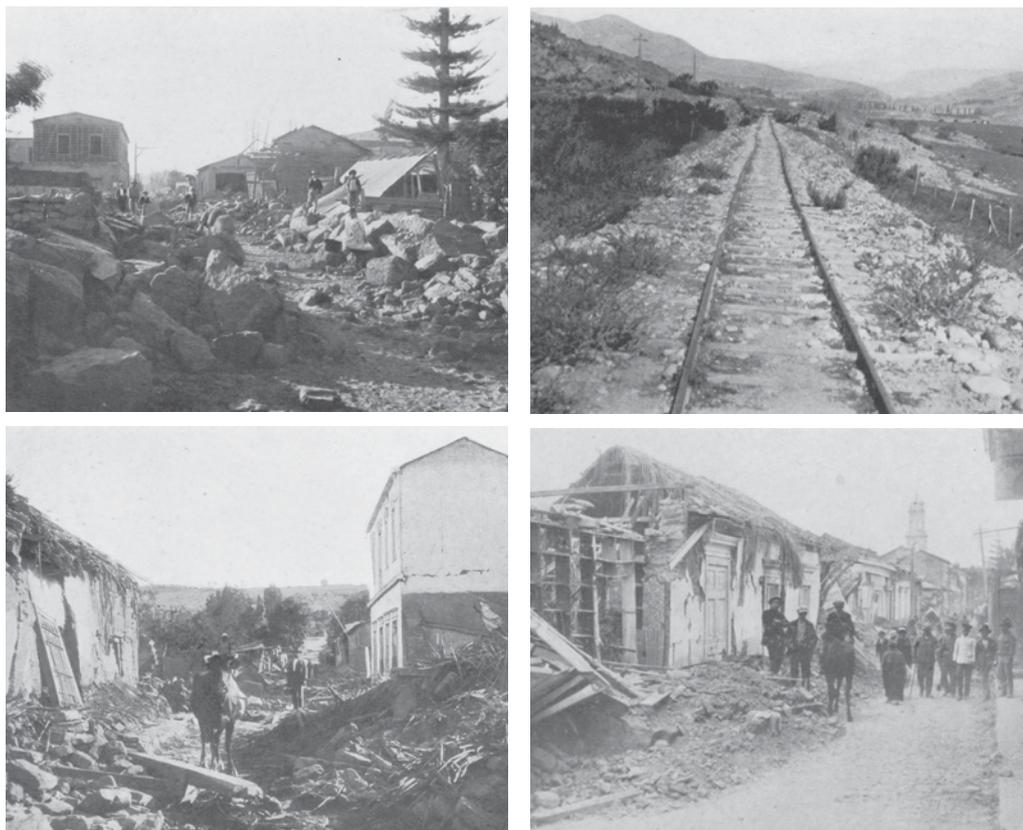
*Figura 4. Efectos que el terremoto de 1922 tuvo en la ciudad de Vallenar. En la esquina superior derecha se observa la traslación y deformación que el terremoto tuvo en las líneas férreas, en este caso, en las proximidades de Freirina. (Colección Miguel Cáceres M.)*
